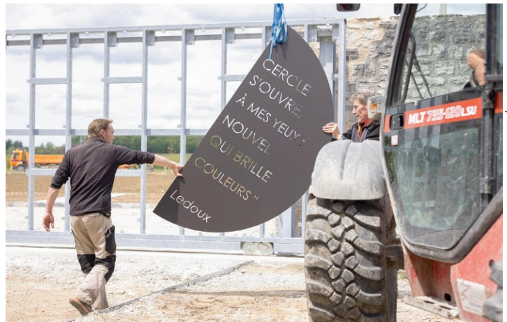
Installation du portail menant aux nouveaux jardins.
